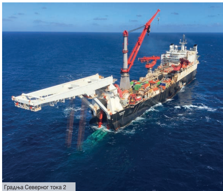
Градња Северног тока 2
