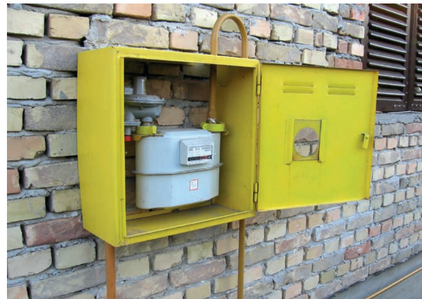
На хитне интервенције излазили смо са заштитном опремом, кућни мерно-регулациони сет
