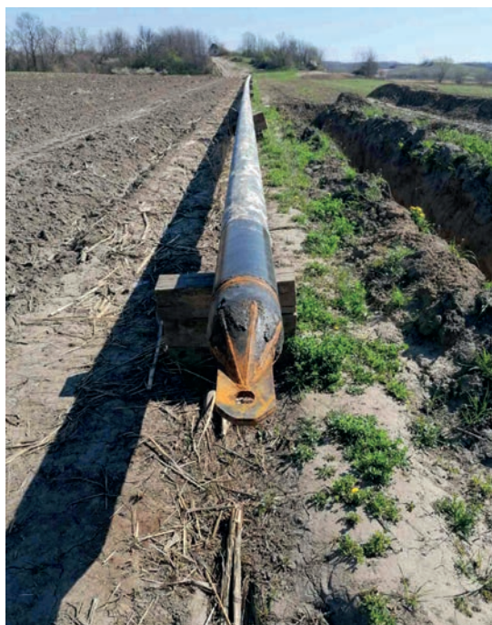
Припреме за подбушивање косо усмереним бушењем
