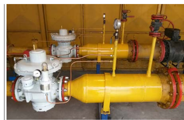
Реконструкција мерних линија на топланама у Београду
