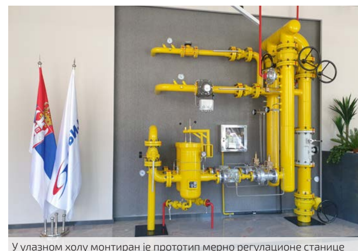
У улазном холу монтиран је прототип мерно регулационе станице
